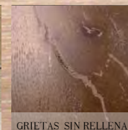
GRIETAS SIN RELLENAR
