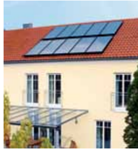
Vitosol 200-FM en viviendas adosadas
