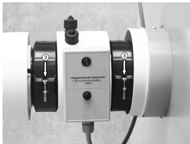
Fig. 43 : Pieza de conexión de la caldera con la abrazadera del tubo de escape
