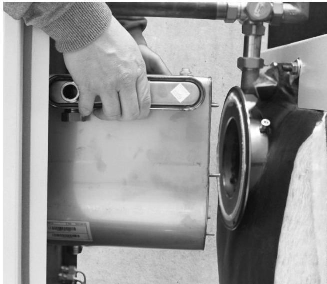
Fig. 49 : Eliminación del cambiador de calor de gases de escape
