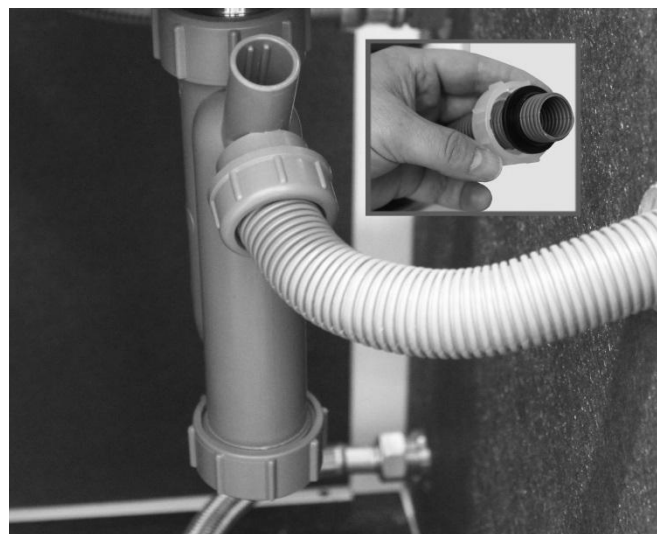
Fig. 7 : Instalación de la manguera de condensado
